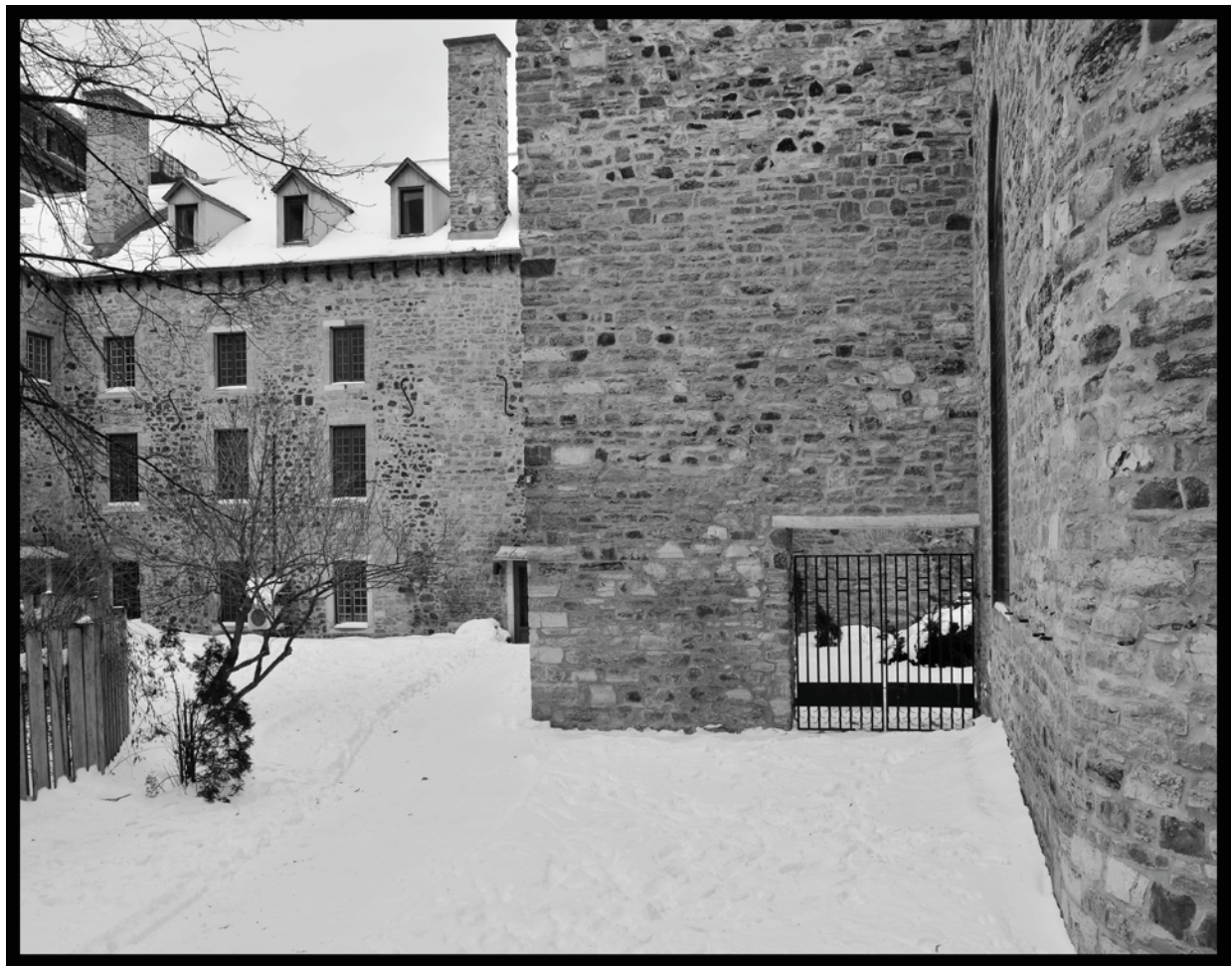
South courtyard of the Hôpital Général des Sœurs Grises, 138 rue Saint-Pierre, 1765–67, incorporating walls of the Maison de Charité des Frères Charon built by the masons Jean Tessier dit Lavigne and Louis Hurtubise, in 1693.
